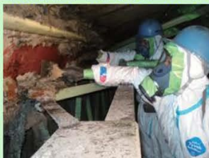
吹付け石綿の除去作業の様子
